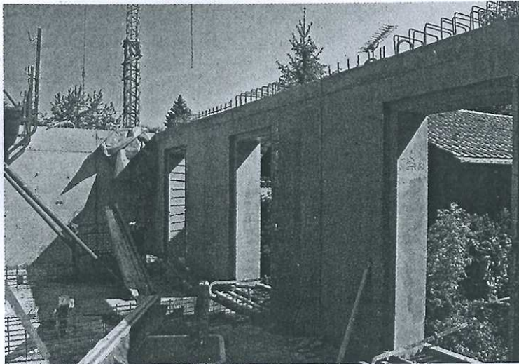
Neben den Decken dienen vor allem die Wände aus Liapor-Leichtbeton als natürlicher Wärmespeicher
